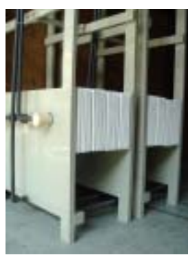
PVDF 片狀濾膜模組 Flat-sheet MBR module
